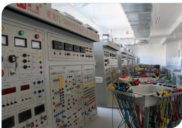
电子电工实训室
